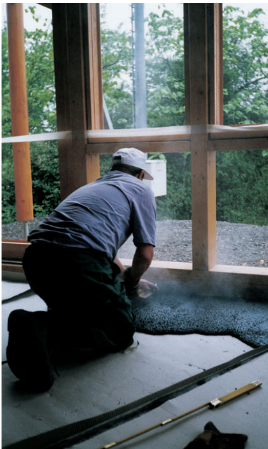
Einbau von Gussasphaltestrich auf Dämmschicht
