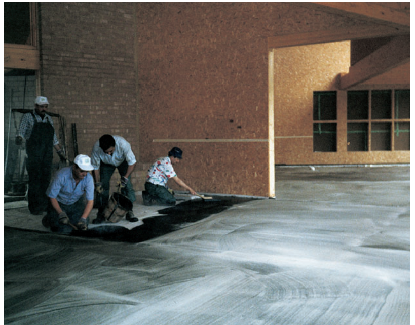
Einbau und fertige Fläche
