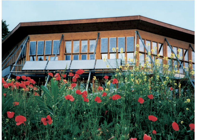
Die Ökostation Butzbach
